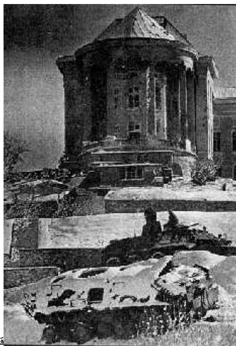
قصر تاج بیک بعد از عملیات الفاء(ترنیزی)
